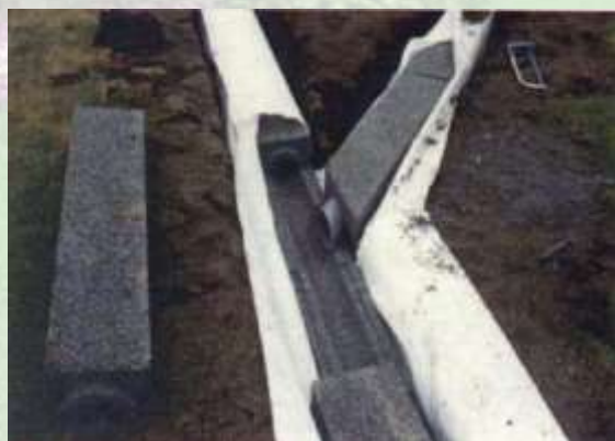
圖3-25 雨水滲透側溝實例
