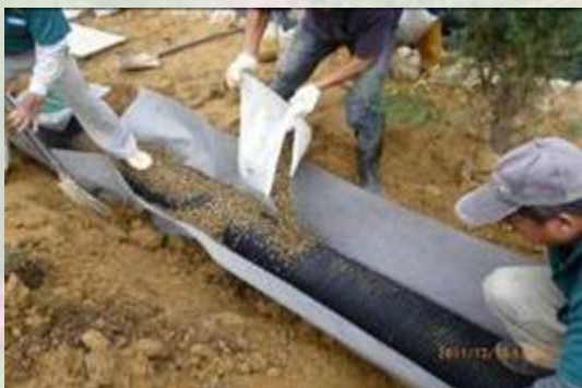
圖3-16 雨水滲透排水管實例
