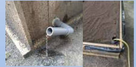
6. 安裝進水管及溢水管
