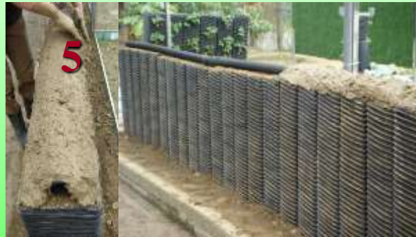
5. SMP-方形網管上半月形滲透網管並覆土固定
