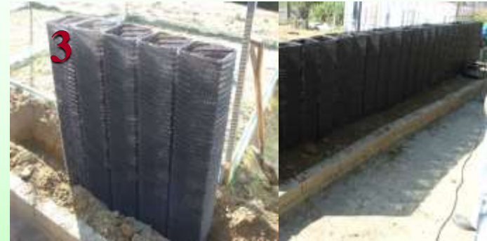
3. 組合之方形網管放入溝渠並覆土固定
