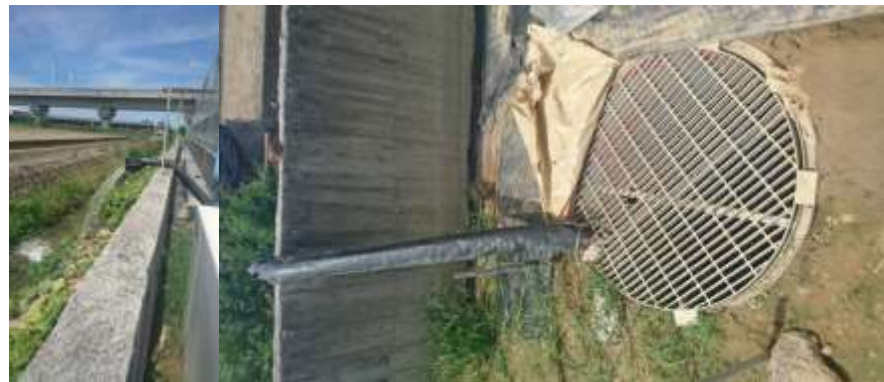
抽離地下水降低地下水位
