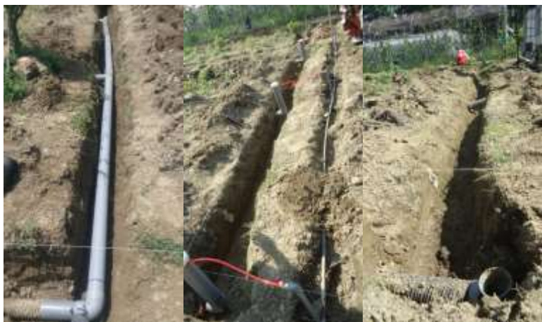
灌溉排水系統配管連接
