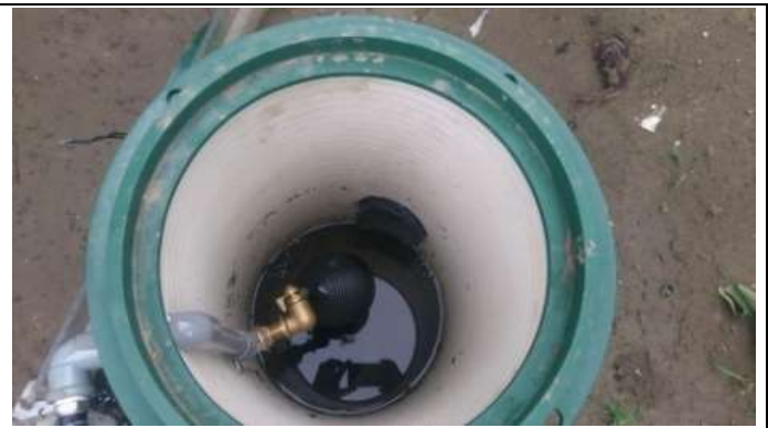
安裝水位控制閥
